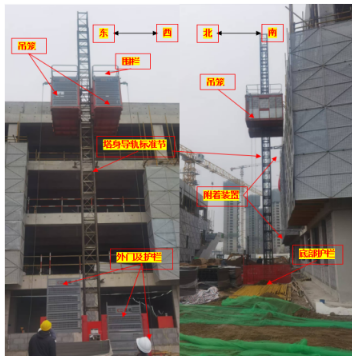
图 3：施工升降机安装整体情况
